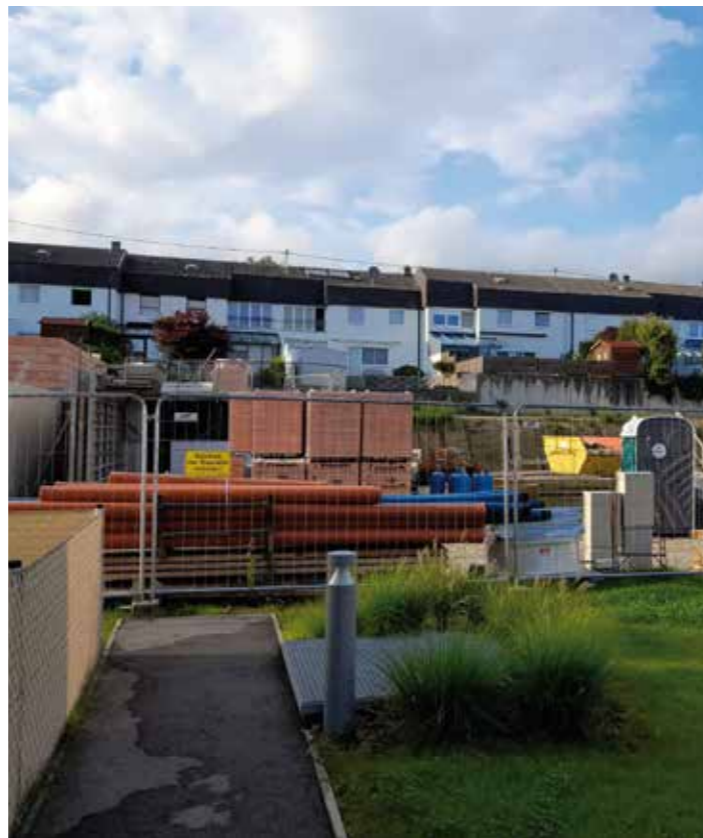
Eine der vielen Baustellen im Sommer 2021 – wie viele sollen noch folgen?
